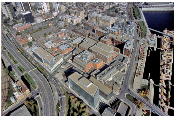
Photo Pierre Malo
